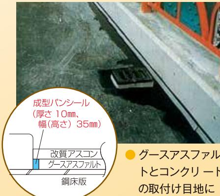
● グースアスファルトとコンクリートの取付け目地に
