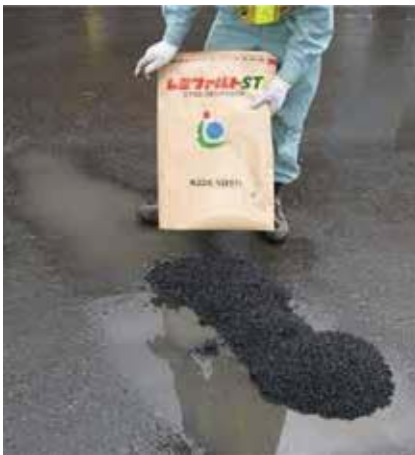
■ 雨天直後の施工
